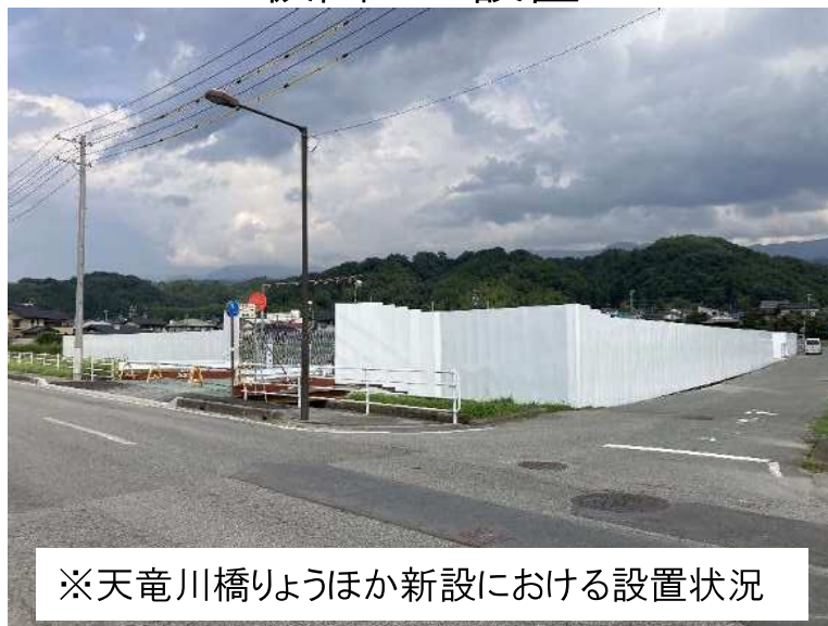
仮囲いの設置
