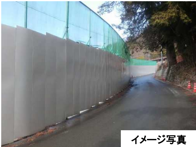
仮囲いの設置
