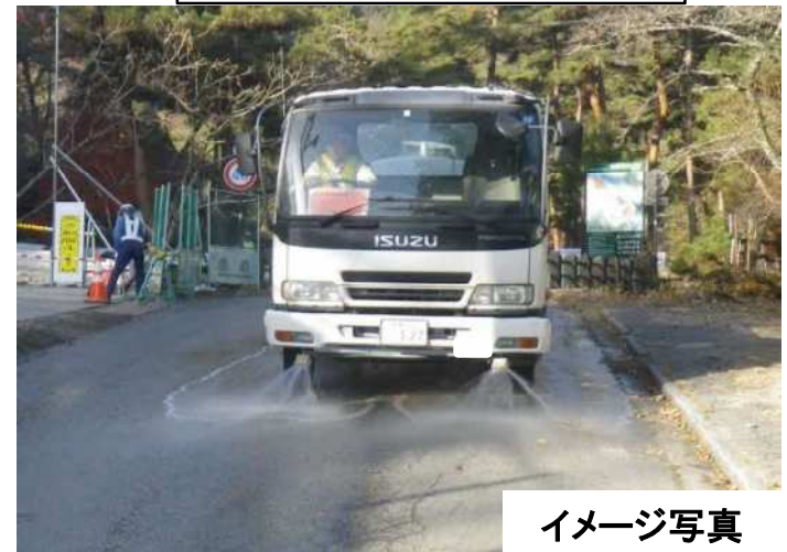
周辺道路への散水
