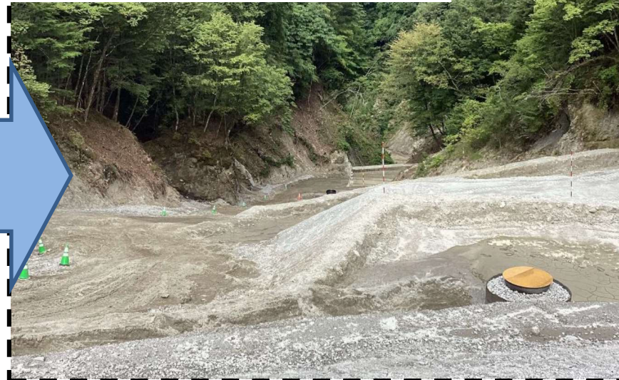
③地下排水管の敷設状況 (R4.10時点)
