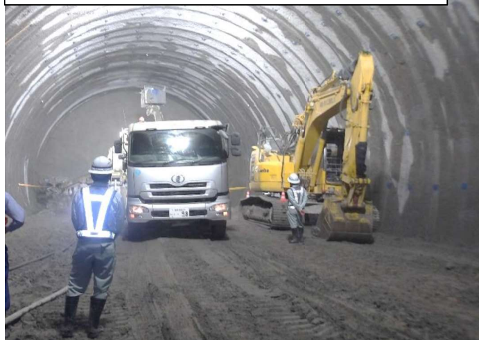
戸中斜坑 施工状況(8月4日)
