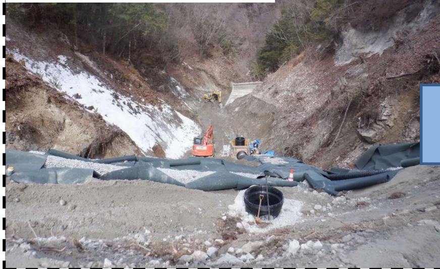
④仮設沈砂池設置状況 (R4.10時点)
