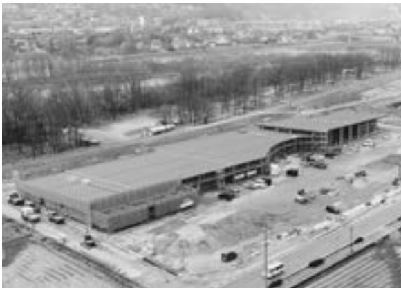
建設が進む道の駅
