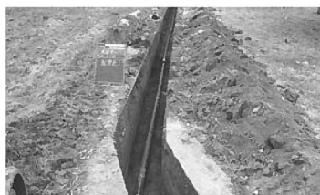
水道本管の更新工事
