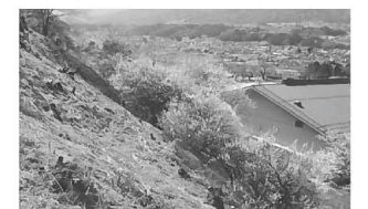
中学校東斜面 伐採後の様子
