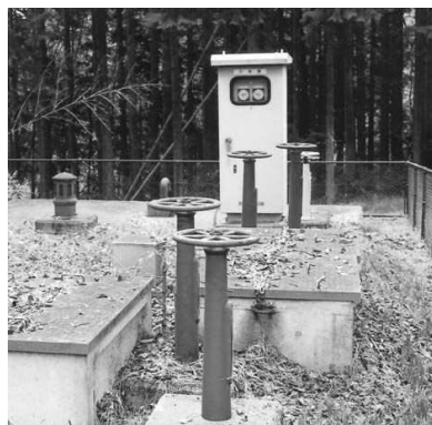
豊丘村営水道の木門配水池
