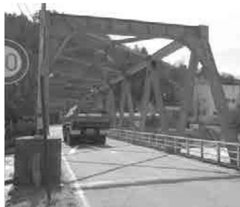
先行着手される宮ヶ瀬橋
