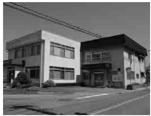
改築される商工会館
