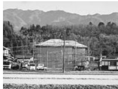
急ピッチで建築されている戸建て賃貸住宅
