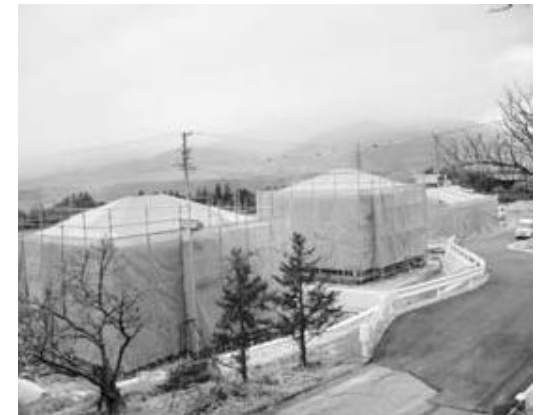
建設が進む大柏賃貸住宅
