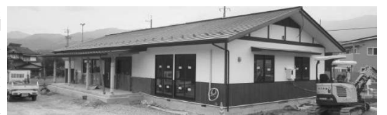
完成間近の北垣外コミュニティセンター
