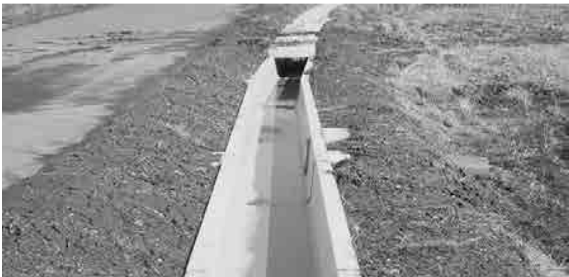
改修された農業用水路
