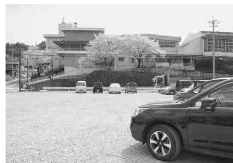
補正で完成した北小学校の駐車場
