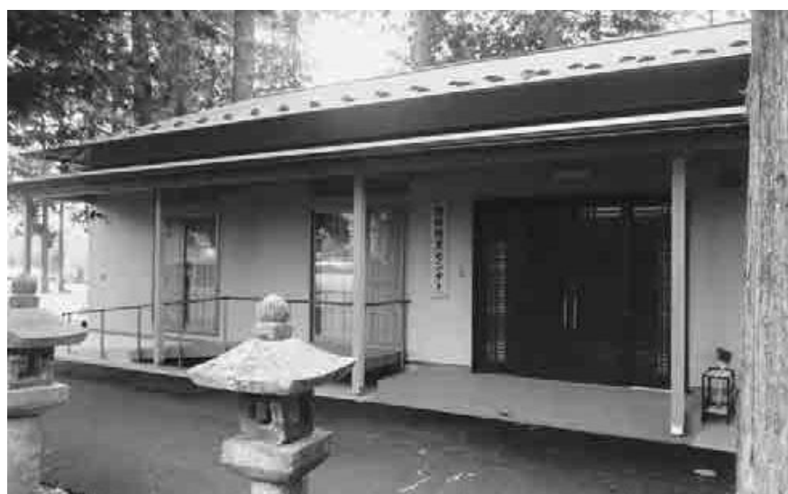
完成した防災センター・50人の避難所に
