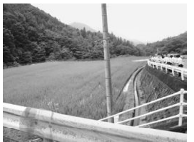
山梨県リニア残土処分場 現場状況視察
