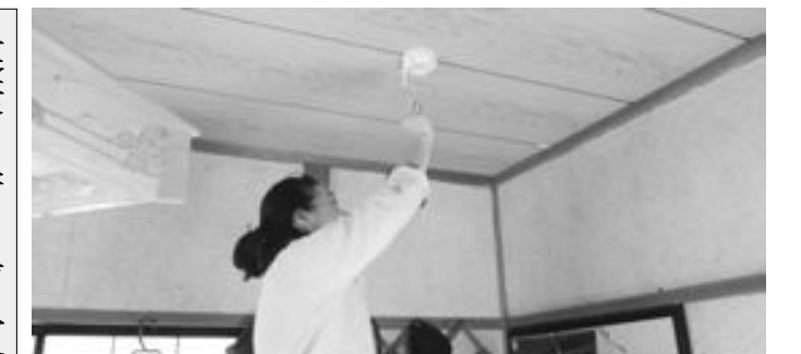
この紐引くと鳴るんだって 火災警報器
