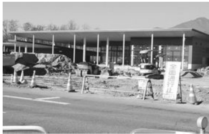
工事が順調に進む当村の道の駅
