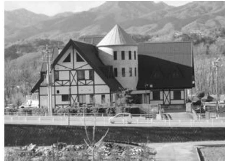
下水処理場「長期契約でいくら安くなる？」
