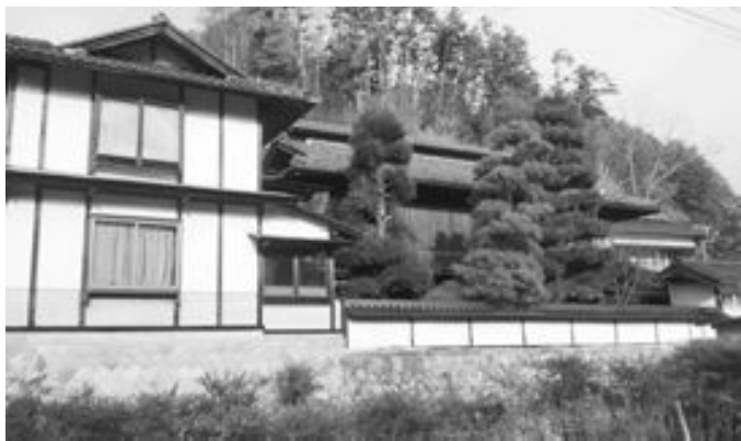
改修が進むゲストハウス
