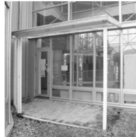
廃止された役場庁舎喫煙所
