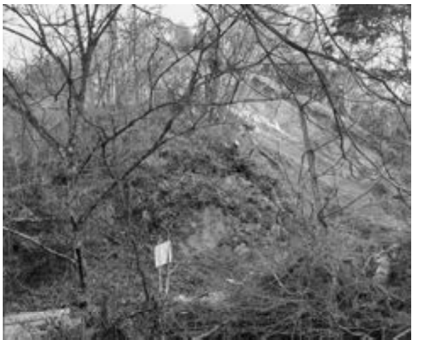
壬生沢崩落の現場
