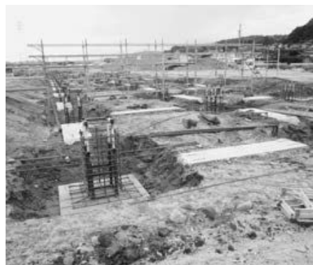
基礎工事が始まった道の駅
