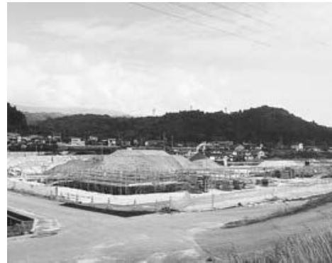
基礎工事が着々と進む村の駅
