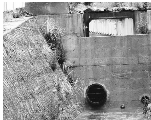
残土置き場の排水溝 (山梨県)
