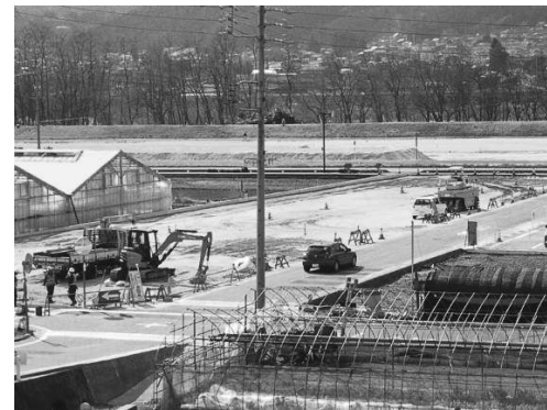
村の駅 造成工事の様子
