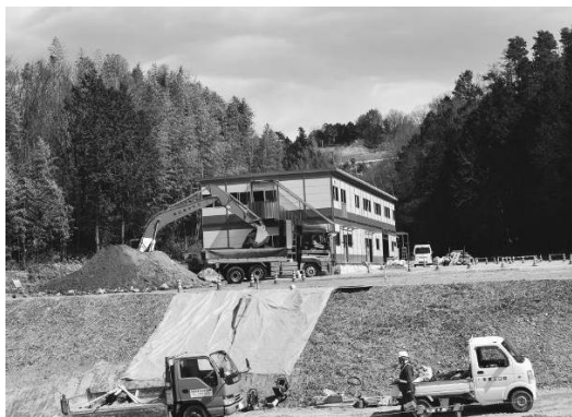
大柏地区に作業員宿舎の建設が進められている
