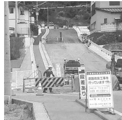
完成まじかの新田取り付け線（林里地区）
