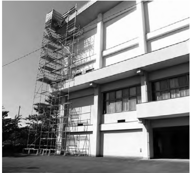
村民体育館の改修工事の様子
