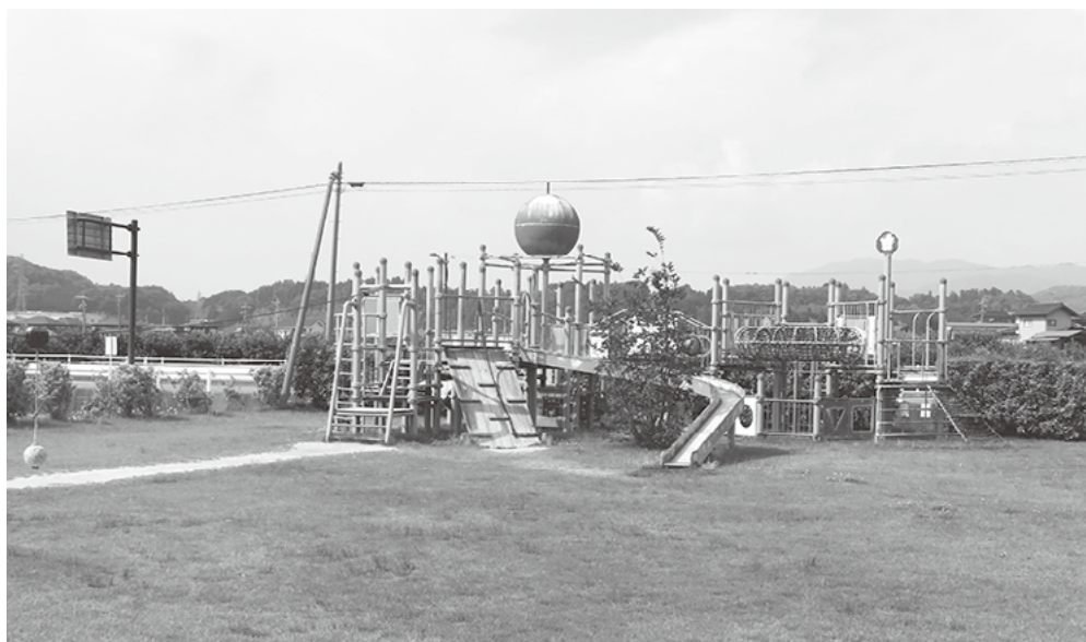
遊具更新工事が始まる りんごっ子公園
