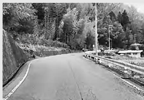
改良工事が行われる南入地籍
