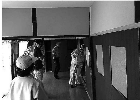
ドアの傾きなどを確認 林里お試し住宅
